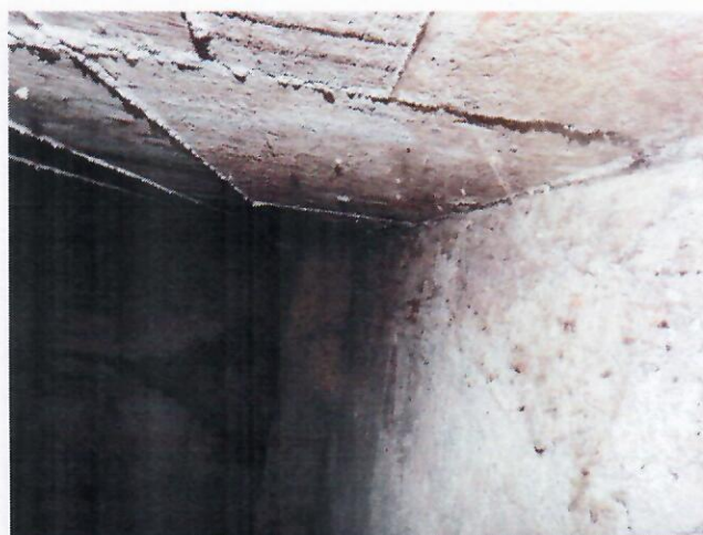
Fotografía 2.26 Cajón de cimentación del edificio "S".
