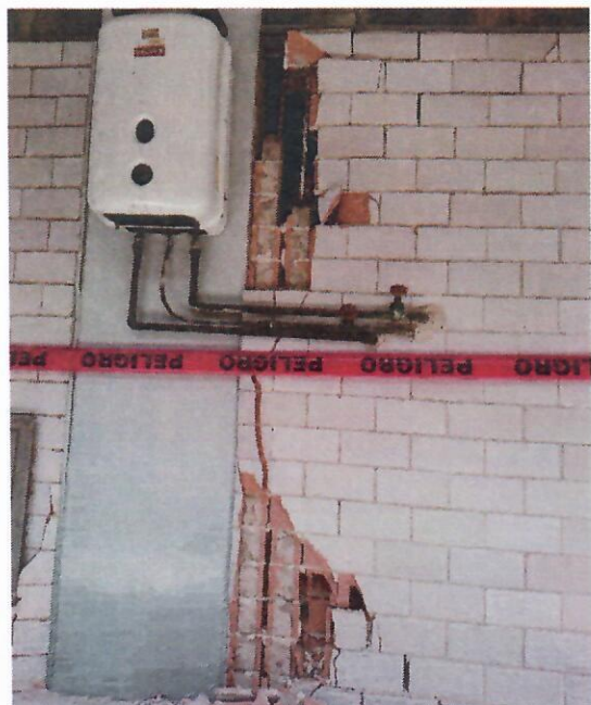
Fotografía 2.15 UNIDAD IZTAPALAPA, septiembre 2017, afectaciones del edificio "S". fractura en muro de barroblock, afectaciones a instalaciones, México.
