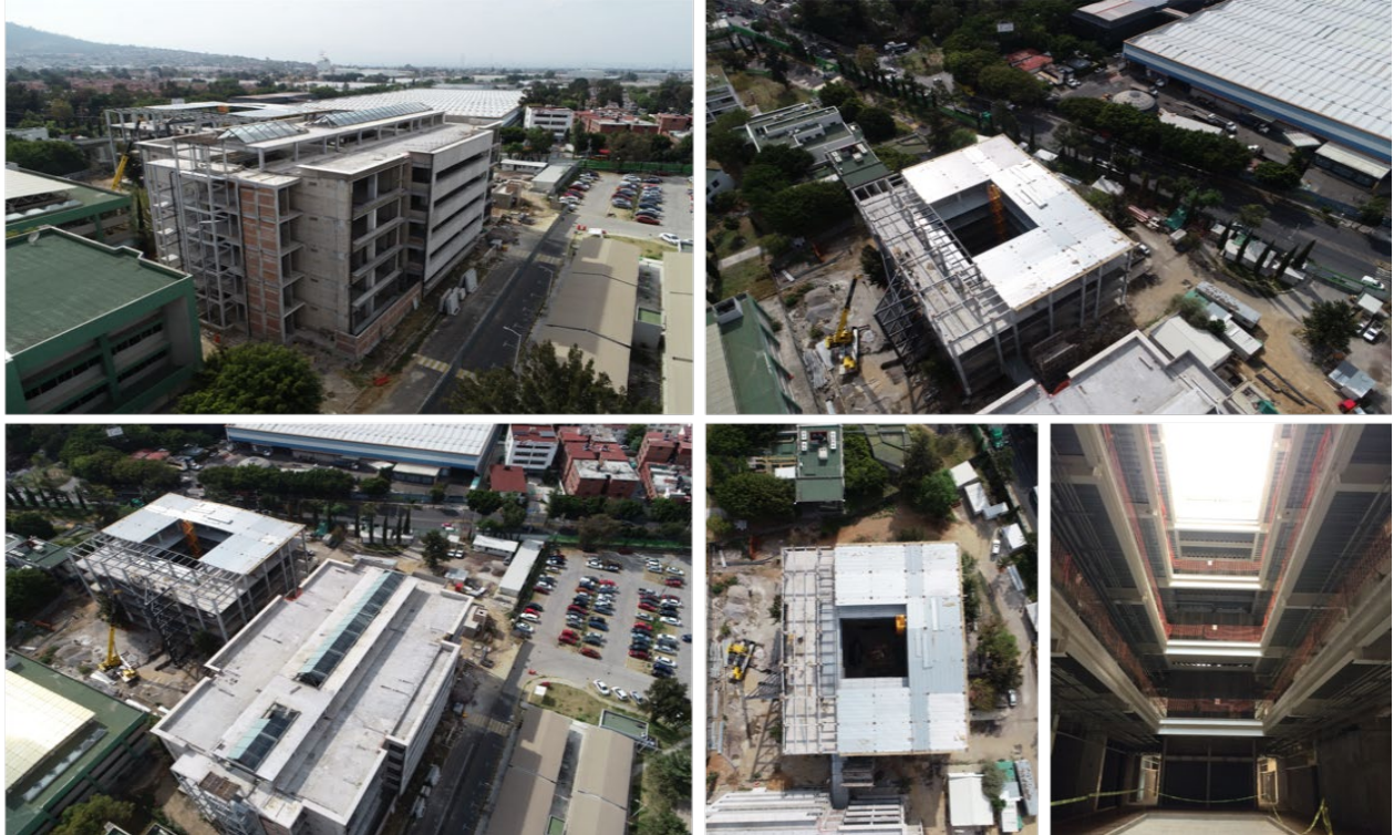
Trabajos de obra para los módulos A y B del conjunto de Ciencia y Tecnología durante enero del 2022.
