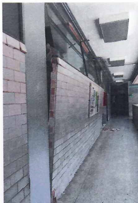
Fotografía 2.12 UNIDAD IZTAPALAPA, septiembre 2017, afectaciones del edificio "S". desplome de muro de barroblock, México
