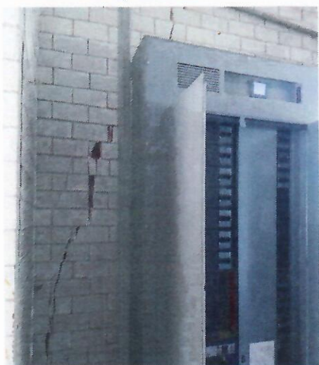
Fotografía 2.15 UNIDAD IZTAPALAPA, septiembre 2017, afectaciones del edificio "S". fractura en muro de barroblock, afectaciones a instalaciones, México.
