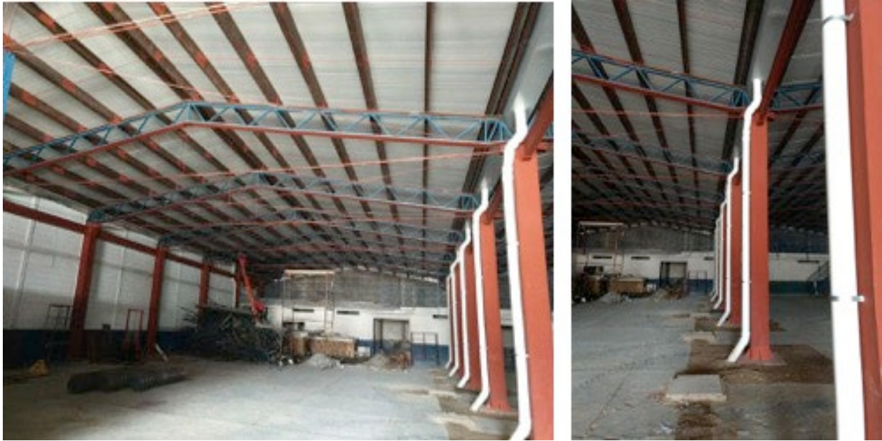
Reforzamiento y cambio de cubierta de la nave del Parque Científico Tecnológico de Oriente (PACTO). Trabajos concluidos a finales del 2019.
