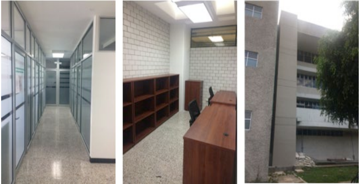
Habilitación de 96 espacios de trabajo para los profesores de la División de CBS y un elevador para pasajeros en el edificio E.
