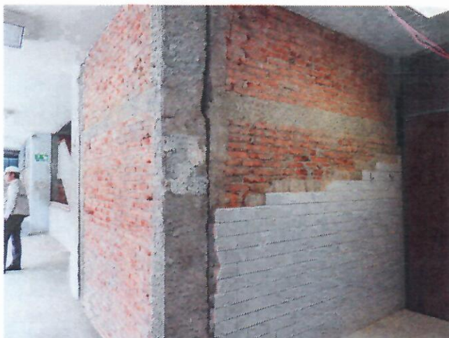
Fotografía 2.32 Doble muro en el cubo de montacargas.
