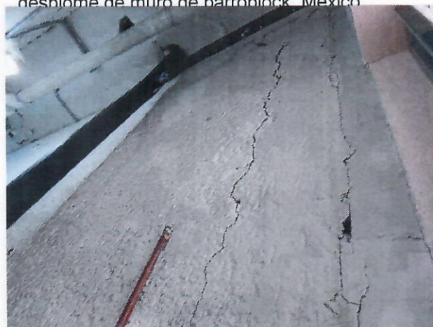
Fotografía 2.12 UNIDAD IZTAPALAPA, septiembre 2017, afectaciones del edificio "S". desplome de muro de barroblock, México
