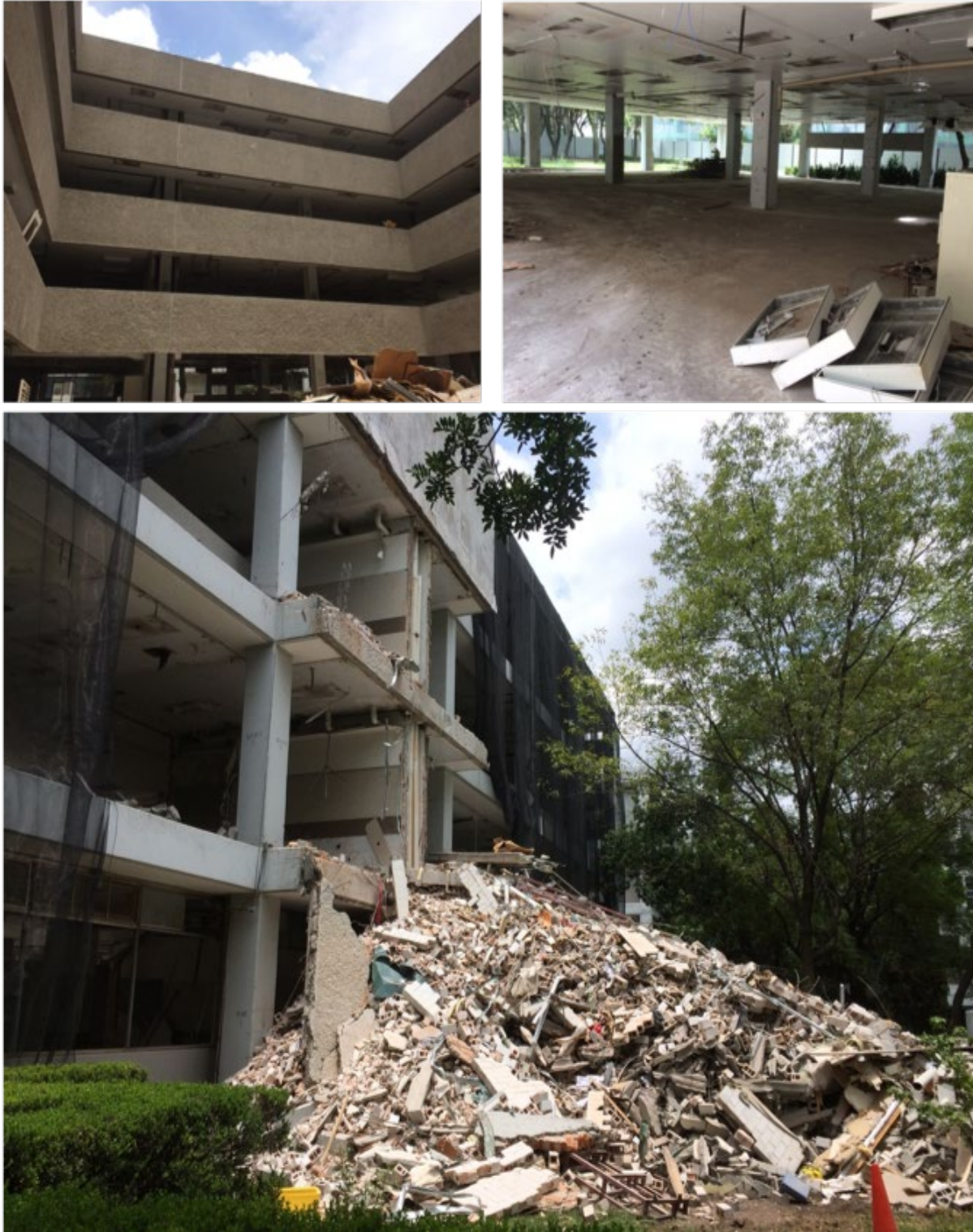
Demolición del antiguo edificio S durante el 2020, casa por más de 40 años de la comunidad de la División de Ciencias Biológicas y de la Salud.
